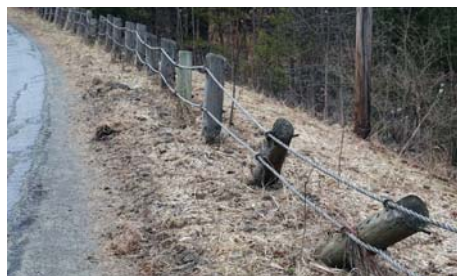
Първите съоръжения се свеждат до дървени огради, каменни парапети или метални релси, които нямат конструктивна способност да задържат автомобил
